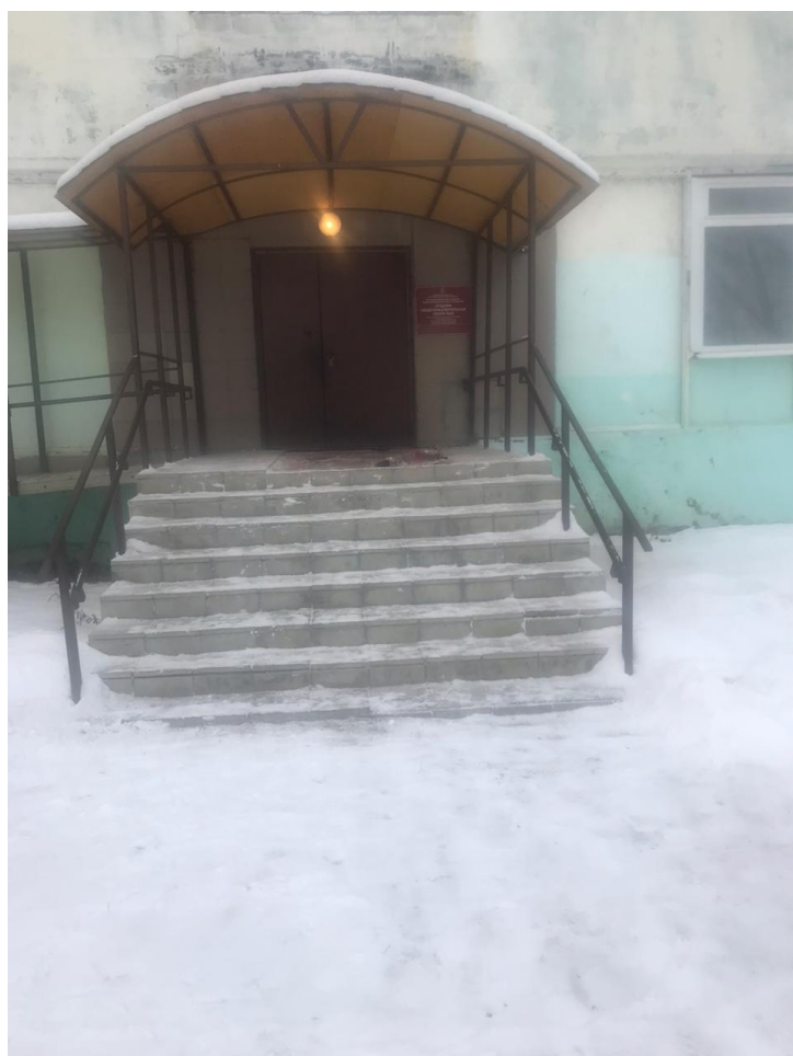
Фото 10. Входная площадка и лестница (вход со стороны начальной школы)
