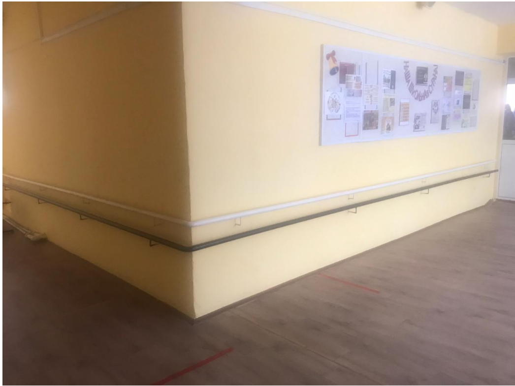
Фото 18. Коридоры МАОУ СОШ №24 (вход со стороны начальной школы)
